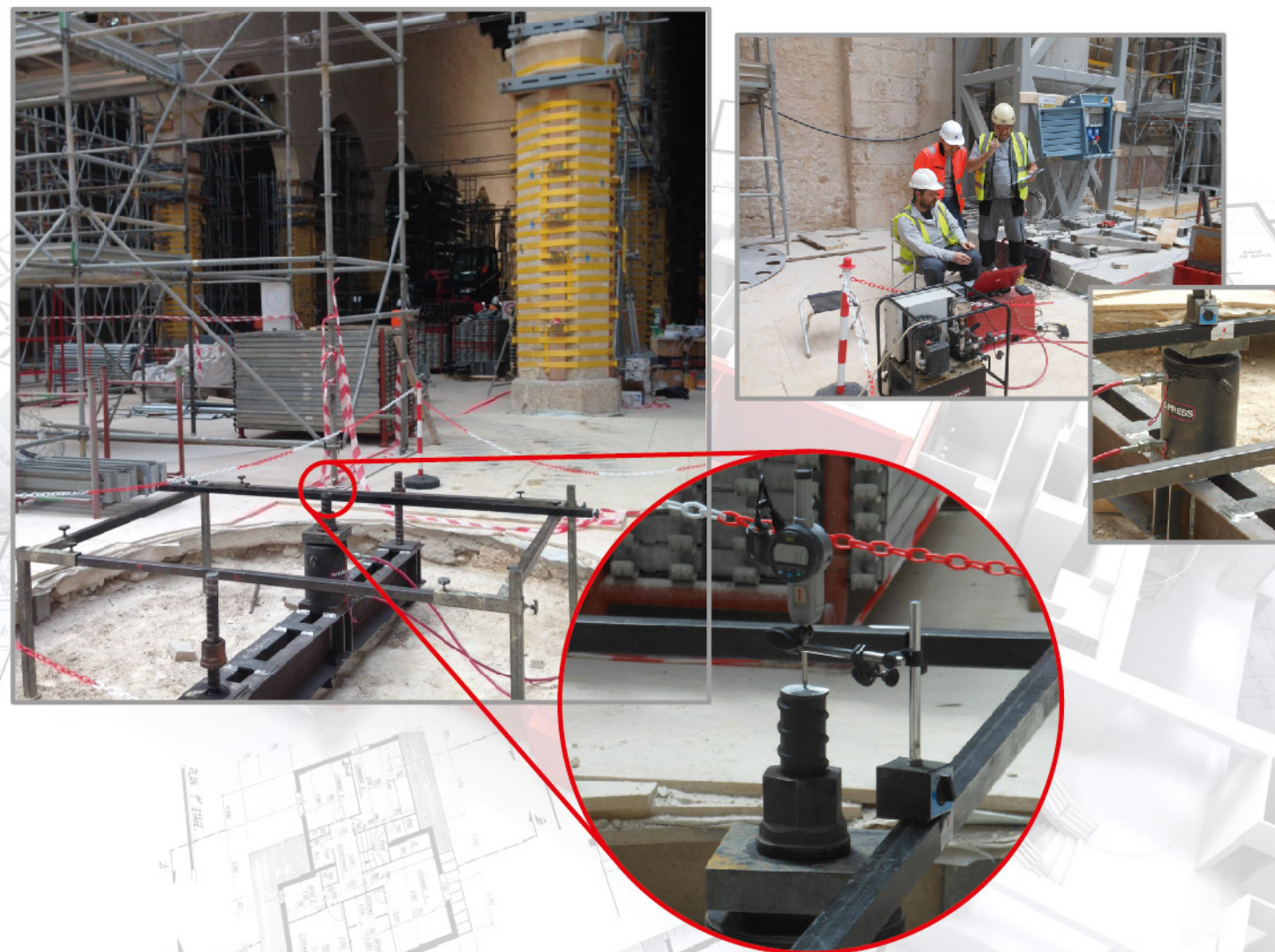
Prova a trazione di Micropalo, Lavori di Ristrutturazione Basilica di S.M. di Collemaggio L'Aquila".
